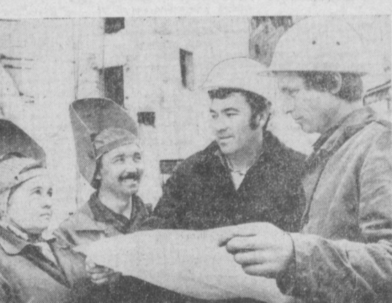
На площади имени Ахунбабаева возводится 20-этажная туристическая гостиница «Москва» на 1.000 мест. Этот уникальный архитектурный ансамбль строит коллектив СУ-75 треста № 11 «Высотстрой» Главташкентстроя. График работ опережается, на объекте широко применяются современные механизмы и прогрессивные методы отечественного строительства.
