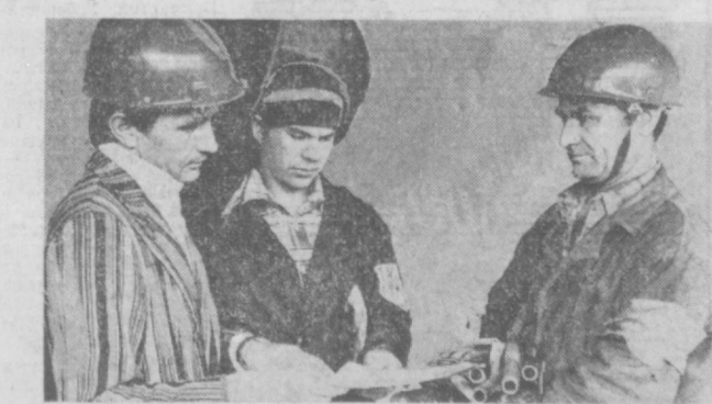
Скоростной монтаж сантехсистем — новый прогрессивный метод строительства работ. Вот оно оное двух лет работают по этому методу труженники треста «Ташантехгазмонтж». Они широко внедряют его в низы, на «высокой скорости» монтируют оборудование на важнейших пусковых объектах города, ударных стройках. Очередной конкурс скоростного монтажа сантехсистем завершился вчера на строящемся комплексе зданий Ташкентского автодорожного института. Этот объект считается пусковым, стройка объявлена ударной комсомольско-молодежной. Было где разгуляться сантехникам, показать мастерство. И не только одним сантехникам, но и их коллегам — строителям СМУ-2 гендиректора треста № 8 Главташкентстрой. Начануне на объекте был проведен конкурс наемщиков этого управления, где высшим производственным показателем добился много передовиков. Итан, включены секундомеры. К работе приступили 54 монтажника из шести бригад всех монтажных управлений «Ташантехгазмонтж». С первых минут соревнования выявились свои лидеры: бригады Р. Кима из СМУ-2, Г. Терзишина из СМУ-3 и Т. Талыбова из СМУ-1. Эти коллективы являются значительными прогрессивными починками. Например, бригада Т. Талыбова первой в республике поддержала рекорд свердловчан «Пятилетнее задание бригады — меньше составом». Подсчитав свои возможности, коллектив уже передал в отставку бригады двух опытных своих монтажников. И это не отразилось на выполнении задания, наоборот, мобилизовало людей на достижение более высоких рубежей: нормы выработки в бригаде возросли. Не отстает от своих соперников и бригада,
