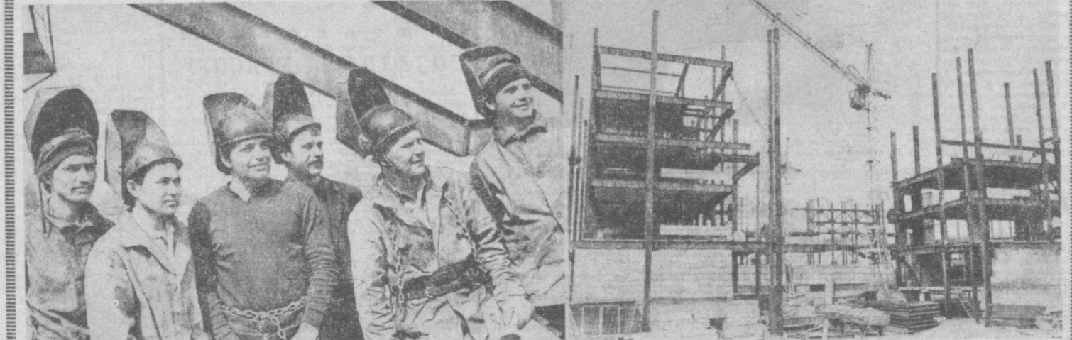
На площади Дружбы народов возводится уникальное здание киноконцертного зала на 4.100 мест. Хорошо трудится здесь комплексная бригада кавалера орденов Ленина и Трудового Красного Знамени Мухтара Хабидуллаева хозрасчетного участка треста № 11 «Высотстрой». Этот коллектив работает под девизом «За пятилетку — десять годовых норм». Особой старательностью отличаются сварщики Р. Рахимов, А. Налимов, Н. Чуфистов, Л. Линов, Ю. Левкович, А. Певченко (на снимке слева направо). Систематически перевыполняют сменные задания, они производят работы с высоким качеством.
