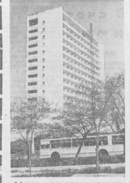
В Севастополе заканчивается сооружение многоэтажной гостиницы «Крым» на 640 мест. Строительство гостиницы (на снимке) ведет СУ-42 треста «Севастопольстрой».
