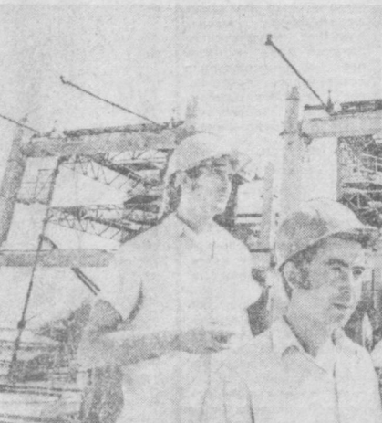
Сейчас на территории завода строится девятиэтажный инженерный корпус. Сооружает его комплексная бригада Альберта Штраумера из передовиков механизированной колонны № 126 строительного треста «Ташпромстрой».
