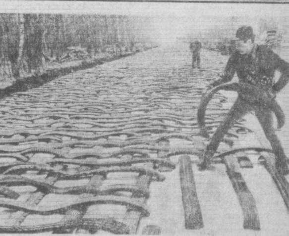
ФРГ. Один из способов применения старых автомобильных покрышек — это укладка в основание строящейся дороги.
