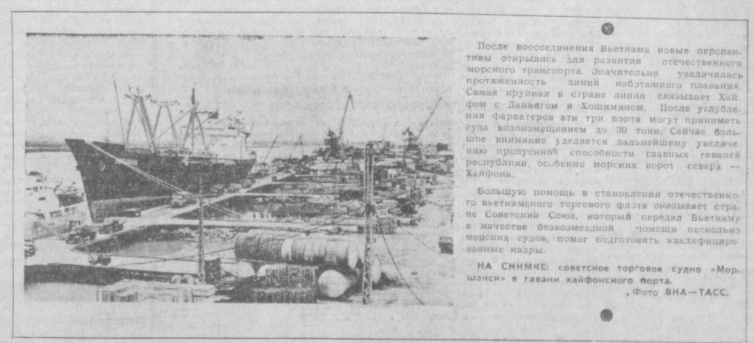
После воссоединения Вьетнама новые перспективы открылись для развития отечественного морского транспорта. Значительно увеличилась протяженность линий наблюдательного плавания. Самая крупная в стране линия связывает Хайфон с Данангом и Хошимин. После углубления фарватеров эти три порта могут принимать суда водоизмещением до 30 тонн. Сейчас большое внимание уделяется дальнейшему увеличению пропускной способности главных гаваней республики, особенно морских ворот севера — Хайфона. Большую помощь в становлении отечественного вьетнамского торгового флота оказывает страна Советского Союза, который передал Вьетнаму в качестве безвозмездной помощи несколько морских судов, помог подготовить квалифицированные кадры. НА СНИМКЕ: советское торговое судно «Моршанск» в гавани хайфонского порта. Фото ВИА-ТАСС.
