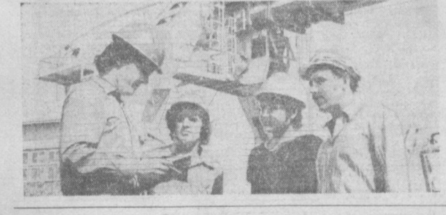
Здесь, рядом с площадкой имени Пушкина, в десятке метров от реки Салар, расположились один из многоэтажных «лазерей» «Ташметростроя». Поорбазированные бульдозеры, «КрАЗы», металлоконструкции, а над всем этим возвышается козловой кран — все это хозяйство в распоряжении коллектива третьего строительного управления.
