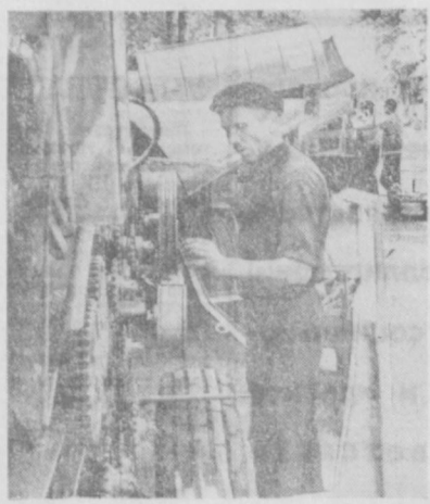
Шестнадцать лет трудится на объединении «Узбесельмаш» слесарь-сдатчик А. А. Пелых. Он собирает очень нужные хлопкоробам в горячую хлопковую страду борошочистители «УПХ-1.5».
