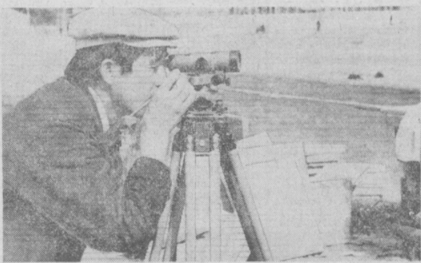
Еще один вход в станцию метро «Дружба народов» в скором времени будет сдан в строй. Сейчас здесь работы в разгаре. Маркшейдер тоннельного отряда № 2 треста «Ташметрострой» К. Сативалдиев со своей помощницей Т. Веселовой (на снимках) определяют верхнюю отметку входа в тоннель. Фото Н. Козинского.
