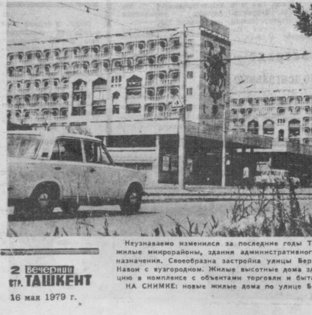
Неузнаваемо изменился за последние годы Ташкент. Выросли новые жилые микрорайоны, здания административного и культурно-бытового назначения. Своеобразная застройка улицы Беруни, связанная проспектом Назов с вузгородом. Жилые высотные дома здесь сданы в эксплуатацию в комплексе с объектами торговли и быта. НА СНИМКЕ: новые жилые дома по улице Беруни. Фото Х. Шадиева.
