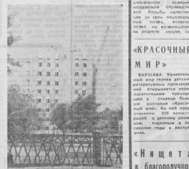
На улице Полторацкого возводится девятиэтажный 36-квартирный жилой дом для работников нефтяной фабрики. Строительство ведет СУ-38 треста № 4.
