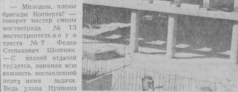
изготовлены на базе мостостроительного отдела № 13.
