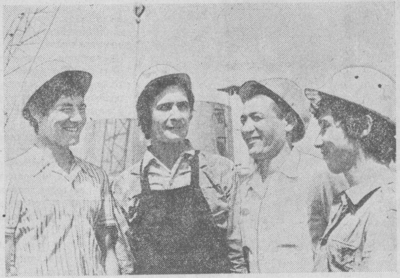
По улице Энгельса сооружается радиотелевизионная передаточная башня. Ее возводит СУ-69 треста «Высотстрой-11» и колонна «Сибстальконструкция».
