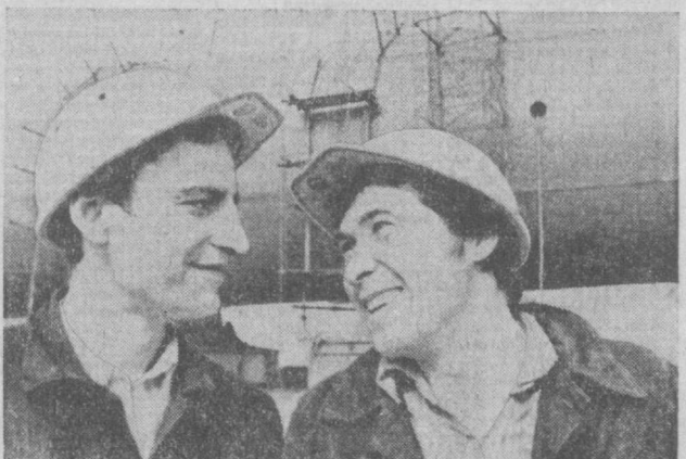
По улице Зигельса возводится новая телевизионная башня высотой 350 метров. Этот уникальный объект сооружают коллективы треста «Высотстрой-11» и механизированной колонны треста «Сибстальконструкция».
