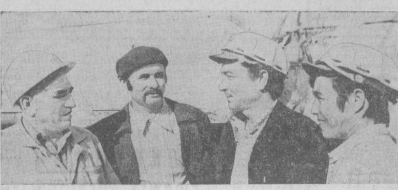
Коллектив строителей, где мастером Джалал Сандалиев (стройуправление № 3 треста № 153 Главташкентстрой) возводит по улице Тимирязева новую столовую.
