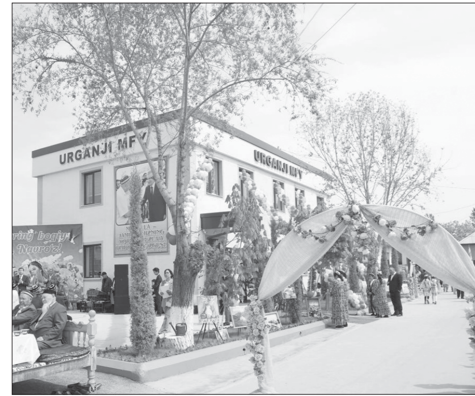
Дар ноҳияи Бувайда барои ҷамоати шаҳрвандони маҳаллаи «Урганҷи» бинои нави замонавӣ ба истифода супурда шуд.
