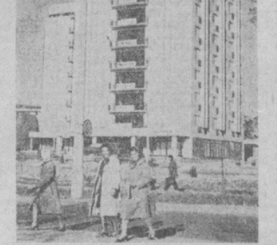
НА СНИМКЕ: новая гостиница Ташкентского сельскохозяйственного института по улице Красновожатинской Куйбышевского района.
