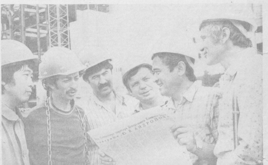
С глубоким интересом изучают материалы VIII сессии Верховного Совета СССР десятого созыва трудящиеся нашего города. Бригада коммунистического труда строительно-монтажного управления «Спецжелезобетонстрой» треста № 11 «Высотстрой» в эти дни возводит вычислительный центр коллективного пользования, сменные месляные здания переполнены на 80 процентов.
