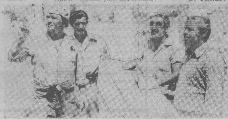
НА СНИМКАХ: специалисты треста «Средэлектромеханизация» еще раз тщательно сверяют рабочие чертежи. На нижнем снимке — бригада А. Матвеева монтирует колонны блок-свинарника.
