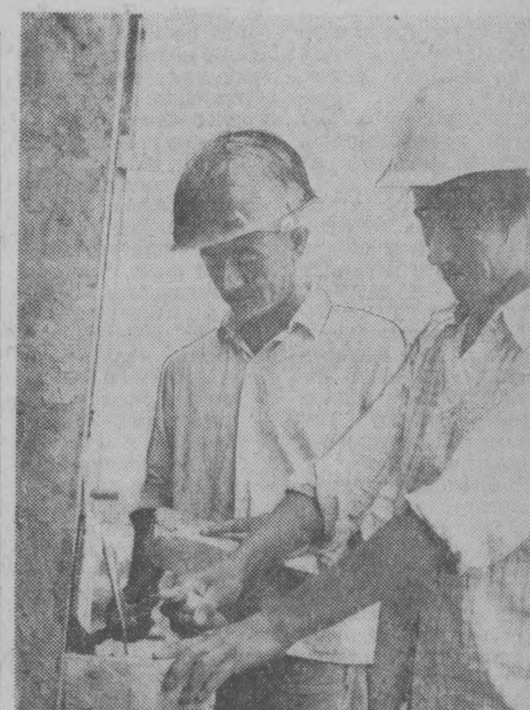
В разгаре пусконаладочные работы на строящемся в Чиланзаре филиале Ташкентского текстильного комбината. В сооружении ткацкого цеха принимает участие бригада М. Лебедева из СУ-7 треста № 6 Главташкентстроя.
