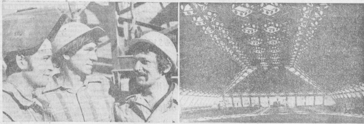
Уникальный объект возводится неподалеку от Центрального зала спорта «Юбилейный». Крытый тренировочный каток сооружают коллективы треста № 6 Главташкентстроя, ТашМУ «Стальмонтаж», СУ-11 «Отделстрой» и другие. НА СНИМКАХ: члены бригады А. Белкин из «Стальмонтажа» Г. Мозгов, В. Калашников и М. Гранник; возводятся спортивный каток. Фото М. Нуриддинова.
