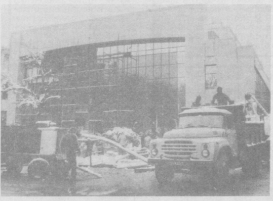
На строительных площадках
