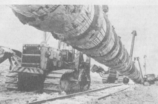
МАРИНСКАЯ АССР. Прокладку дюкера по дну Волги ведет комплексная бригада треста «Востокводотрубопроводстрой», возглавляемая Героем Социалистического Труда Анатолием Филипповичем Сиволовским. Это сооружение станет частью газопровода Ямбург—Западная граница, по которому голубое топливо будет отправляться на экспорт. Водная преграда преодолевается в сложных погодных условиях. Многотонный дюкер ляжет в более чем двухкилометровую траншею, проложенную по дну реки.
