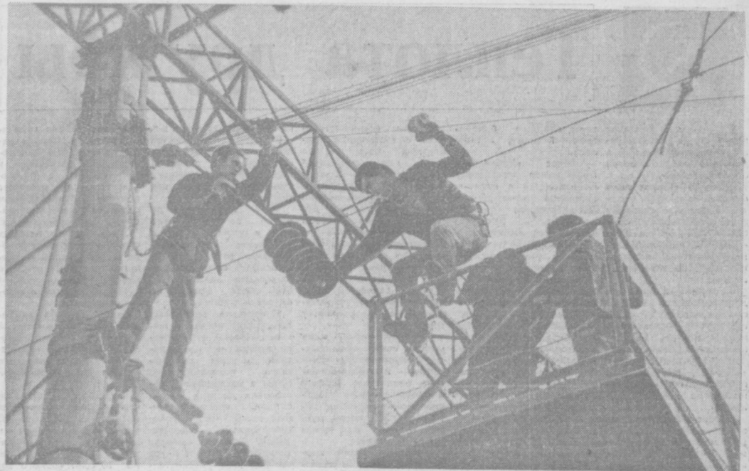
Скоро начнется движение электрических поездов по маршруту Ташкент—Чиназ. Сейчас здесь идет наладка и проверка электропроводов. НА СНИМКЕ: члены передовой бригады, которой руководит Н. Денисов (Ташкентский энергоучасток № 1 Среднеазиатской железной дороги), ведут наладку проводов магистрали.
