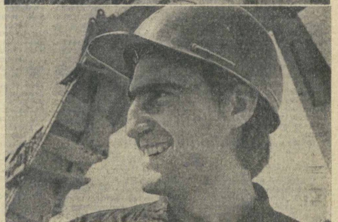
Высокими темпами ведется прокладка Ташкентского метрополитена. Его строители трудятся с опережением графика. На снимках: сверху — мастер передового участка А. И. Корзин и лучший прорабчик А. А. Цирунов добились хороших производственных показателей на строительстве станции «Чиланзарская»; внизу — отлично трудятся на возведении станции «Хамза» П. Я. Руксин, владеющий несколькими свежими специальностями. Фото И. Глауберзона
