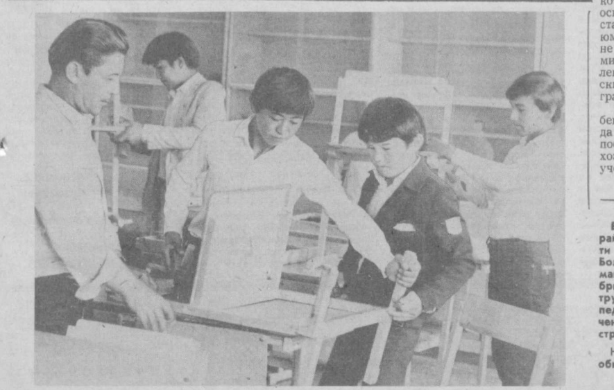
В школе № 2 Ильичевского района Сырдарьинской области в разгаре текущий ремонт. Большое участие в нем принимают ученические ремонтные бригады.
