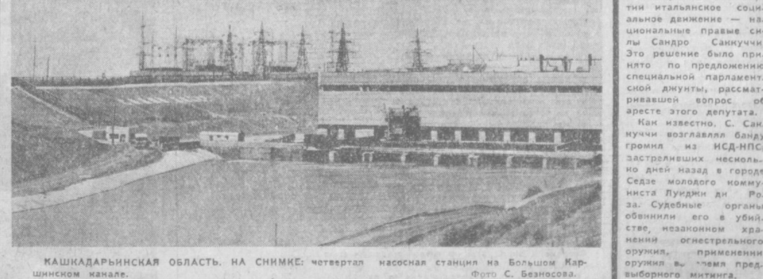
КАШНАДАРЬНСКАЯ ОБЛАСТЬ. НА СНИМКЕ: четвертая насосная станция на Большом Маршинском канале.
