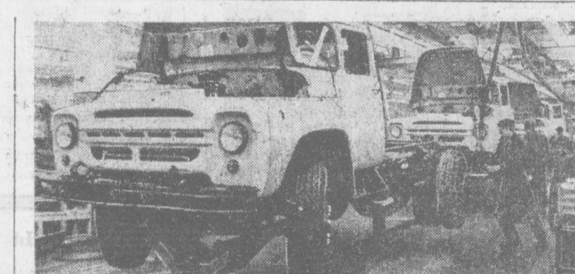
НА СНИМКЕ: сборка грузовых автомобилей «ЗИЛ-130» на конвейере Московского автомобильного завода имени Лихачева. Фото В. Соболева.
