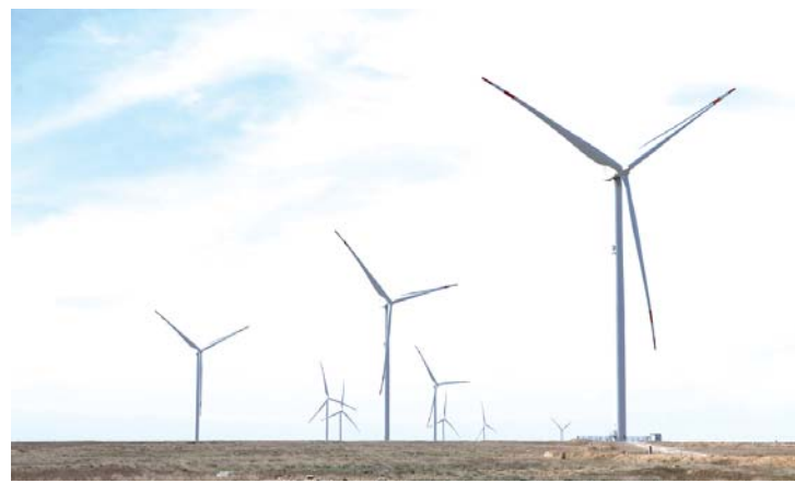
Ветряные турбины ветроэлектростанции «Жанатас» мощностью 100 МВт в Казахстане.
