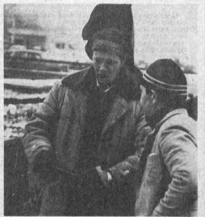
ПАИВАНДЧИ Сергей Кочубей шаҳар ободлаштириш Бош бошқармасига қарашли 1-таъмирлаш-қурилиш бошқармасида кўп йиллардан бўён самарали меҳнат қилиб келмоқда. У айни кунларда бетон конструкцияларини монтаж қилиш билан шуғулланмоқда.
