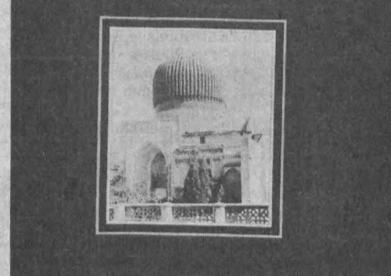
Архитектурное созвездие эпохи Темура Architectural glories of Temur's era
