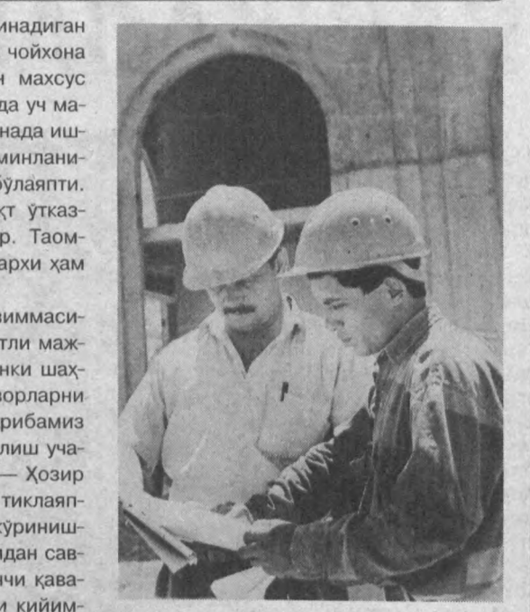
Қурилишга жалб этилган бригадалар орасида энг илғори Едгор Акбаров бошчилик қилаётган жамоа экан. Бригадир билан суҳбатлашамиз.
