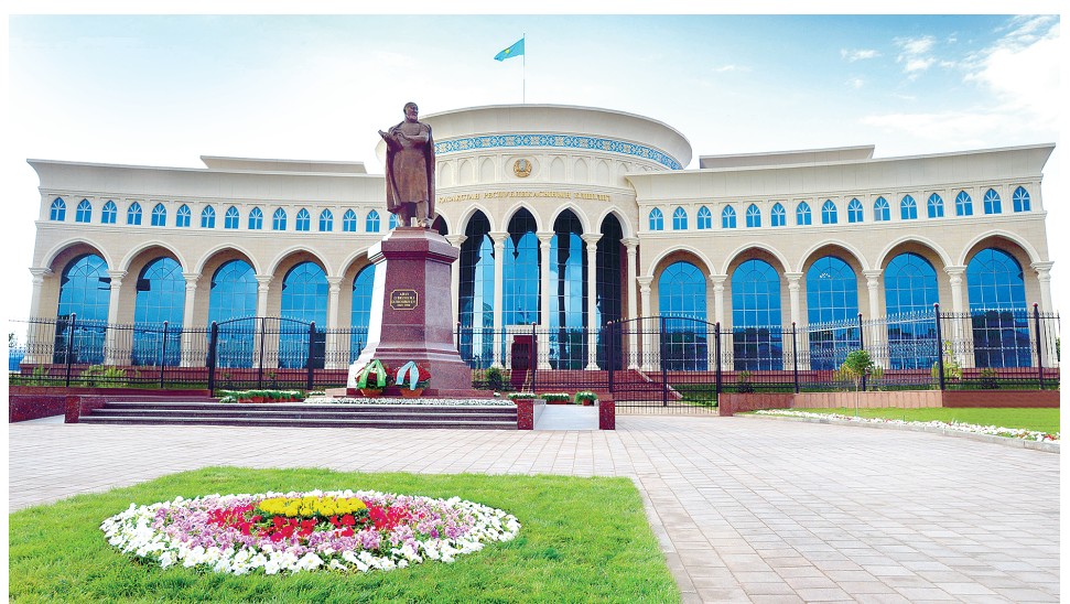
Қозоғистон Республикасининг мамлакатимиздаги элчионасининг янги биноси ҳамда Абай Қўнонбоев хайкали ўзбек ва қозоқ халқлари муштарак қадриятларининг яна бир ёрқин тисмолига айланди.
