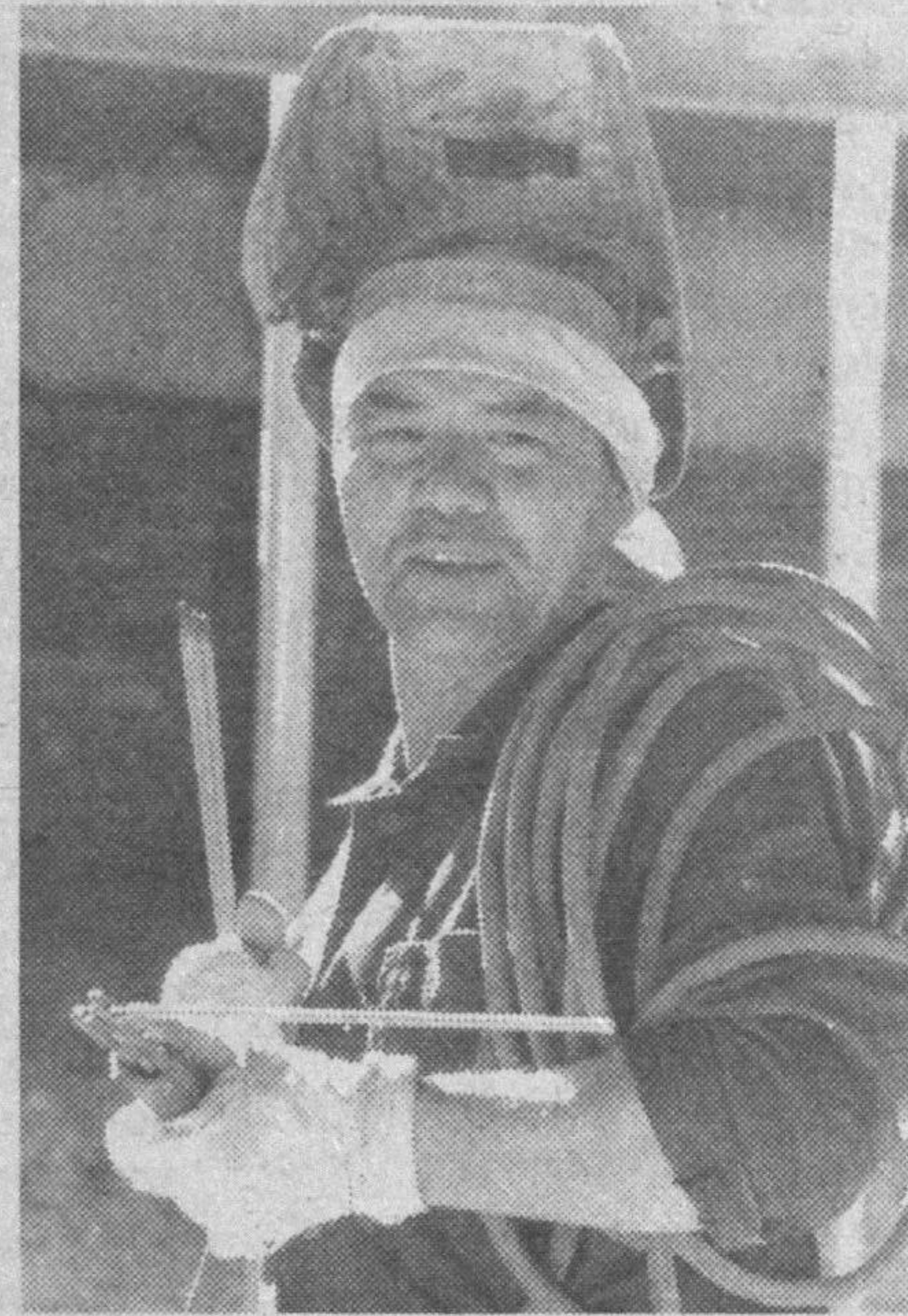
В Яккасарайском районе столицы по улице имени Кунаева, где сегодня ведется строительство трех семизатных жилых домов, на одном из объектов монтажные работы ведет электросварщик О. Акбаров. Фото Т. НИГМАТУЛЛИНА.
