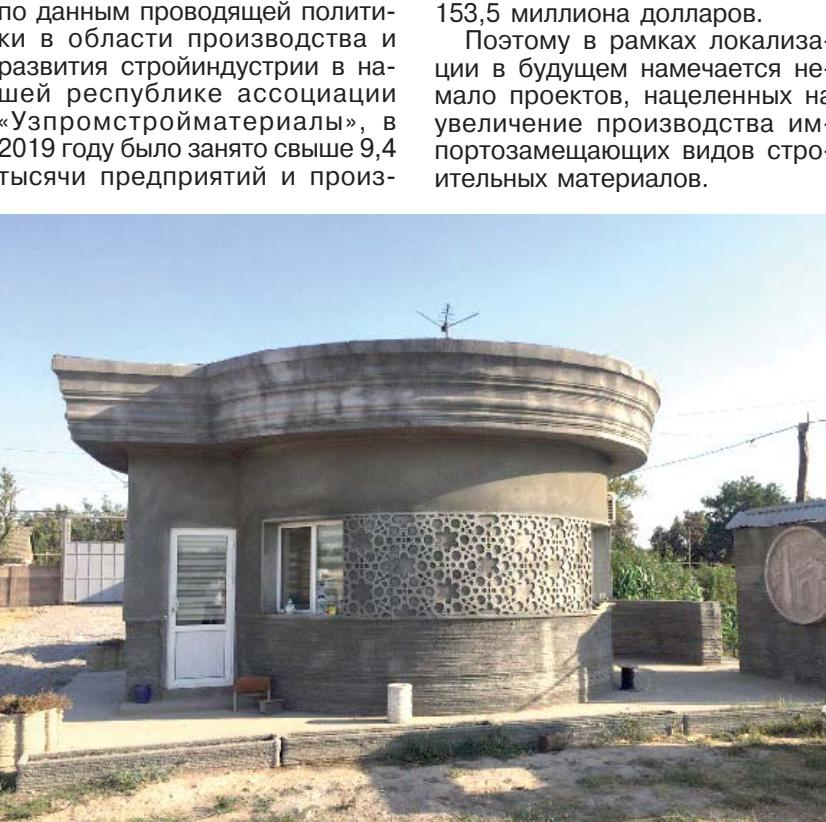
Первое здание, построенное за 48 часов в Узбекистане с применением строительного 3D-принтера, разработанного узбекскими учеными ООО «NOVAPRINT».
