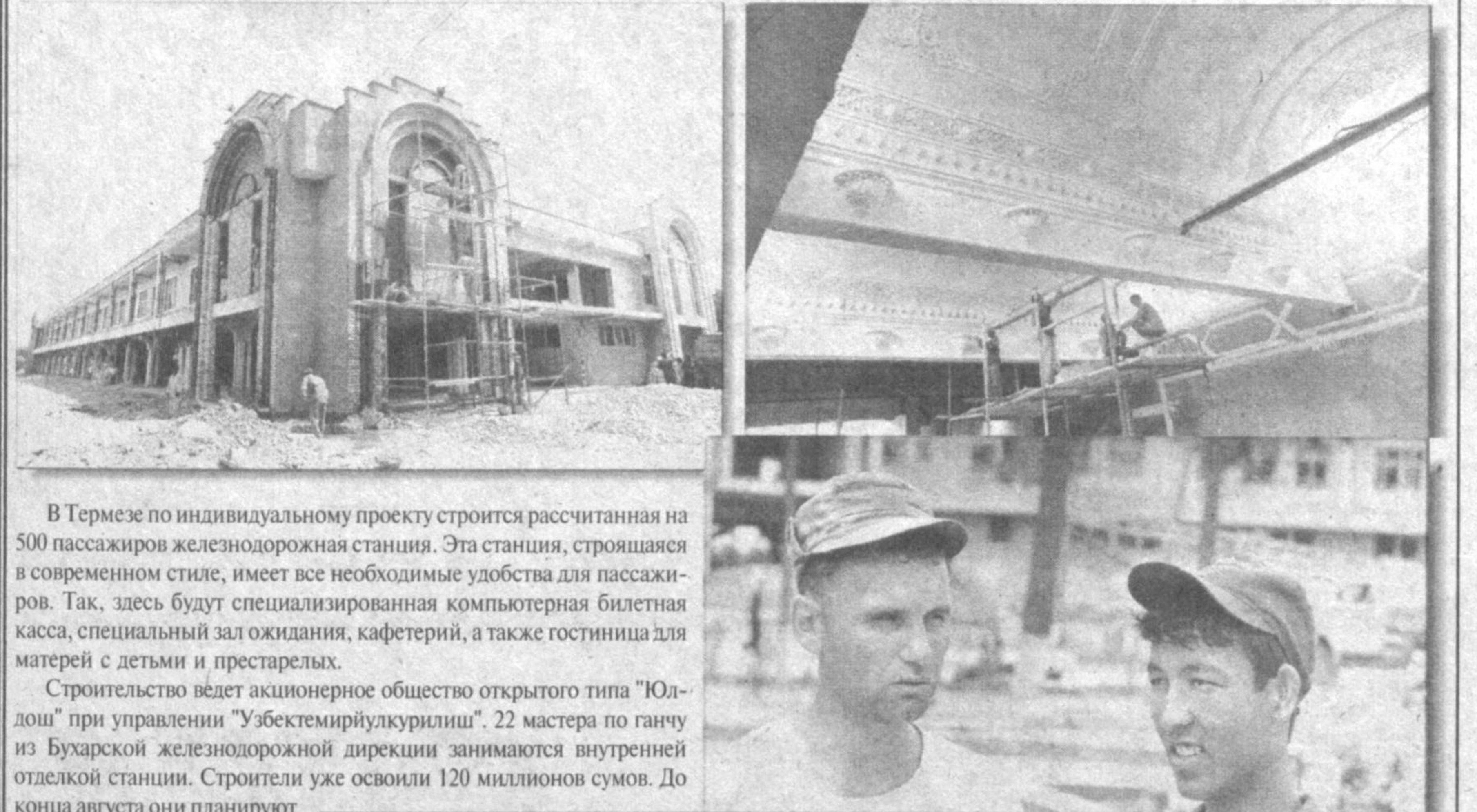
В Термезе по индивидуальному проекту строится рассчитанная на 500 пассажиров железнодорожная станция. Эта станция, строящаяся в современном стиле, имеет все необходимые удобства для пассажиров. Так, здесь будут специализированная компьютерная билетная касса, специальный зал ожидания, кафе-терий, а также гостиница для матерей с детьми и престарелых.
