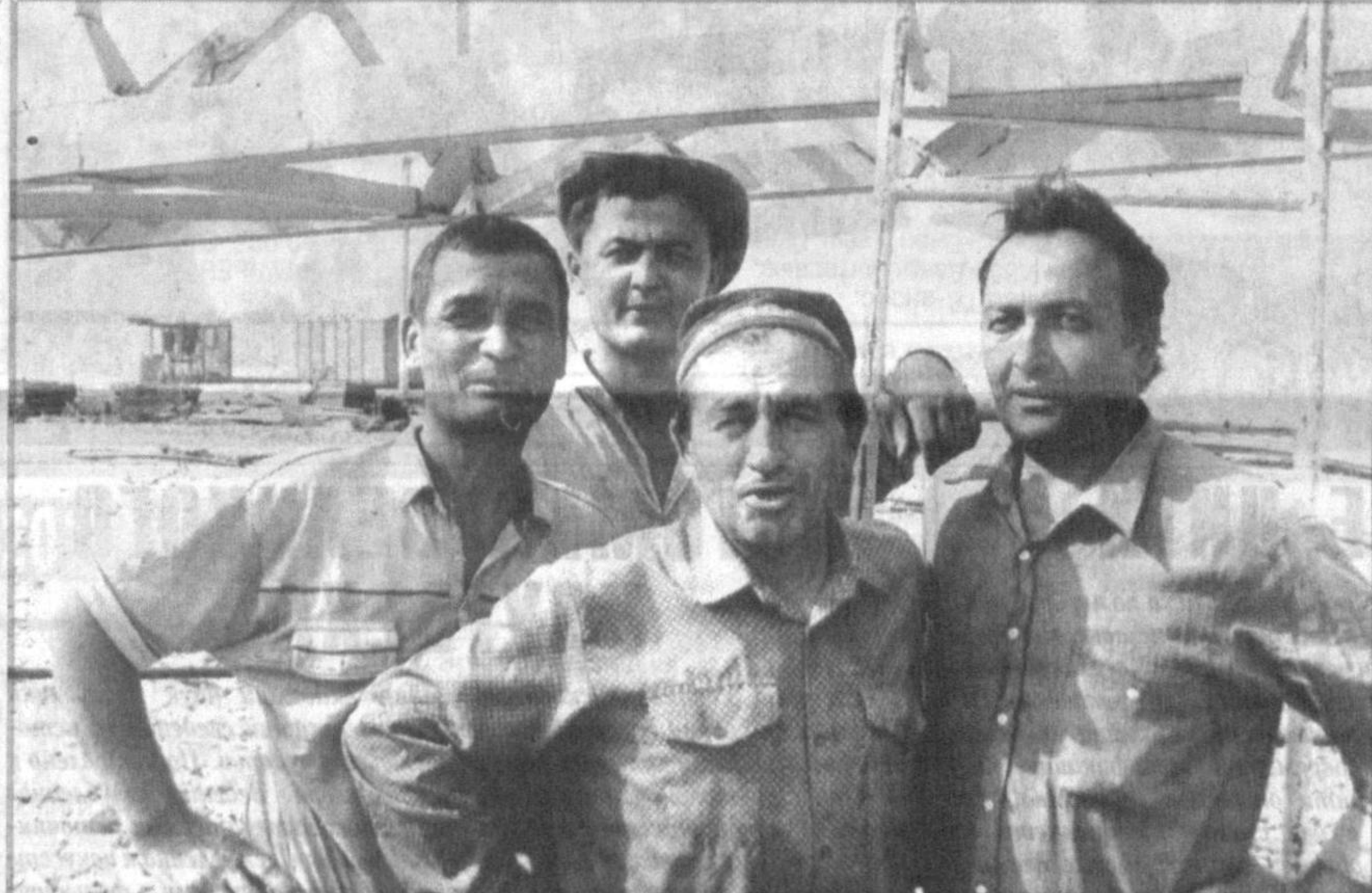
В Элликалинском районе быстрыми темпами идет строительство канала «Бустон» протяженностью 35 километров. Сейчас завершается сборка шагающего экскаватора. Он позволит еще более ускорить ход строительных работ. Монтажные работы выполняет ангресное общество «ИРГТО».
