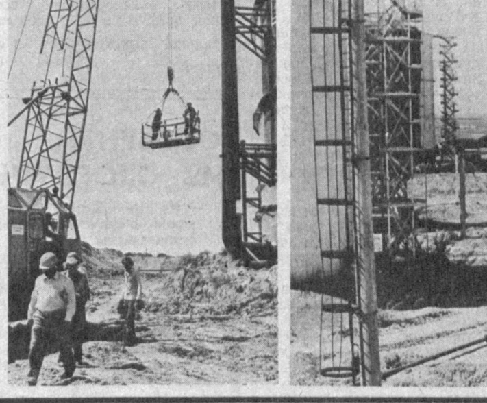
Строительство объекта строительное
