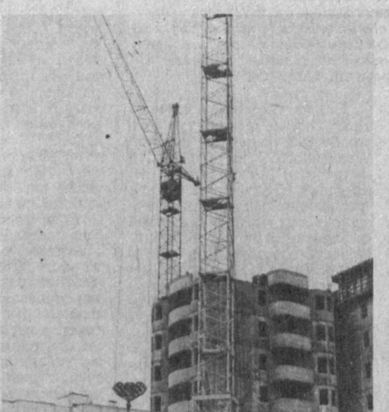
Специалисты строительного монтажного управления № 4 треста экспериментального строительного объединения «Сифат» закончили возведение девятого этажа нового 128-квартирного монолитного шестнадцатиэтажного дома на массиве «Сергели-8». — Строительство дома из керамзитобетона начато в сентябре прошлого года, — говорит начальник участка СМУ-4 Александр Лапин. — Это второй из запланированных 4 монолитных 16-этажных домов, возводимых нами. Строительство идет с опережением графика — сооружаем по полтора этажа в месяц. Планируем закончить монтаж всего дома в сентябре. НА СНИМКАХ: начальник участка СМУ-4 А. Лапин (справа) и монтажник Р. Хайбуллин; на строительстве нового 128-квартирного монолитного шестнадцатиэтажного дома. Фото С. ВЕЛИЧИКИНА (УзА).
