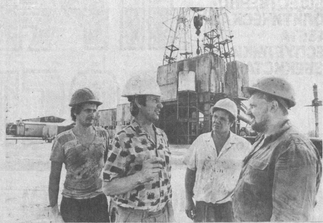
На Мингбулакском нефтяном месторождении идут буровые работы. На помощь нашим нефтяникам приехали буровики с Камышинского бурового управления Волгоградской области. С помощью импортных буровых установок работы, рассчитанные на 2-3
