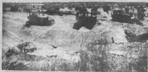
В Дружинском районе Хорезмской области начато строительство магистрального газопровода Газли — Нукус. Мощная стальная труба протяженностью 348 километров и диаметром 1.220 миллиметров позволит не только стабилизировать подачу газа в Хорезмскую область, но и «прорубить» окно в республику ближнего зарубежья.
