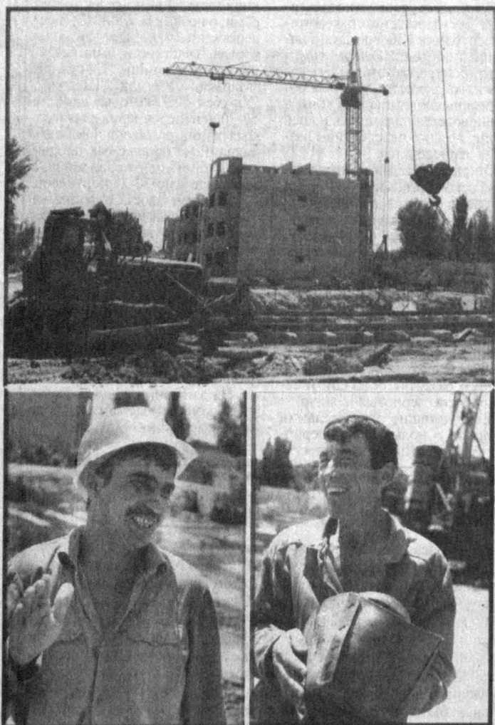
С каждым днем хорошеет наш город. СУ-60 домостроительного комбината Ташкилстрой приступил к строительству семи 16-квартирных домов на 5 квартале массива Чиланзар.
