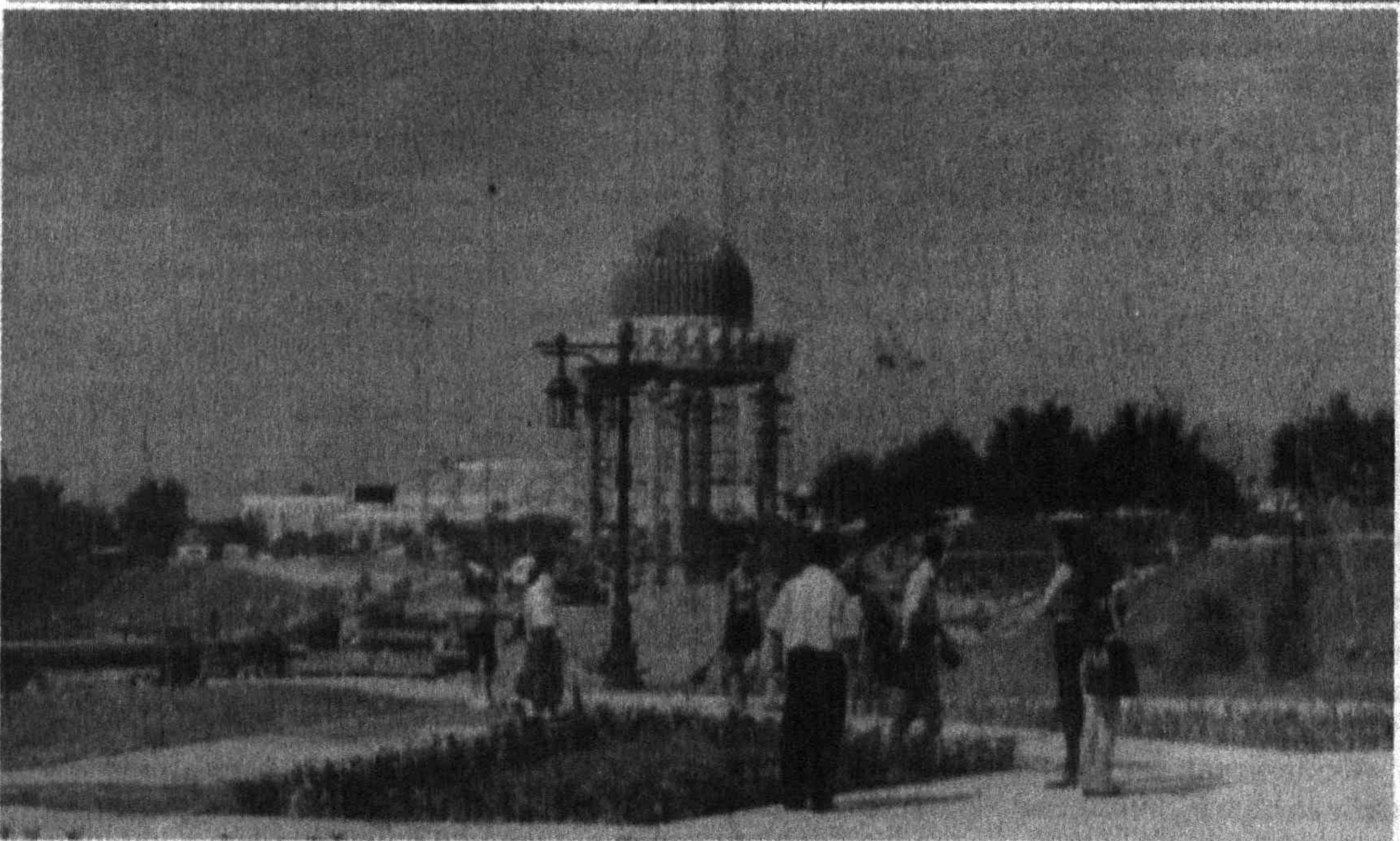
“Шаҳидлар хотираси” ёдгорлик мажмуи қурилиши ниҳоясига етиб қолди.
