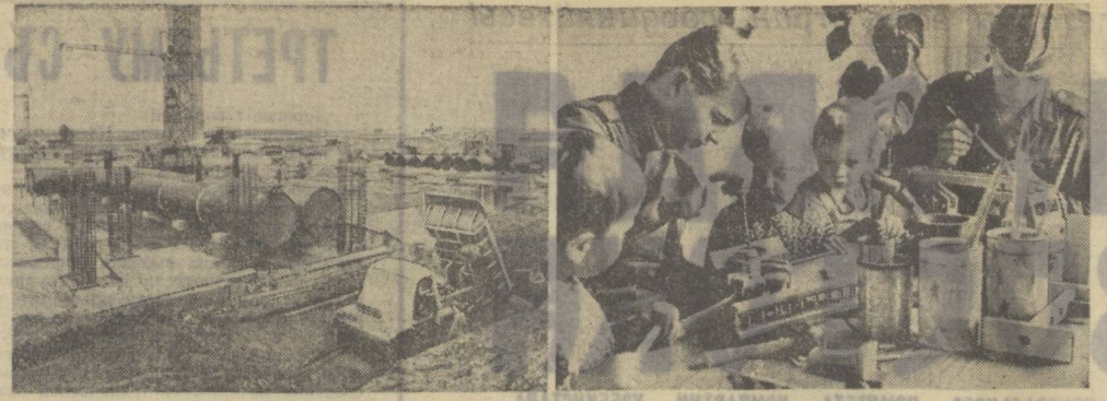
«Почерады» — одна из новых электростанций, которые вступят в строй действующих в ближайшие годы — годы четвертой пятилетки. Строительство теплового станция ведется в Северо-Западной Чехии. Солдаты Национальной народной армии ГДР Петер Хенкель (слева) и Рюдигер Лей в составе и воспитанники ясель имени Валентина Терешковой в городском районе Третлов. Одна из добровольно взятых на себя «обязанностей» шефов — чинить игрушки, «разобранные» любознательными малышами.
