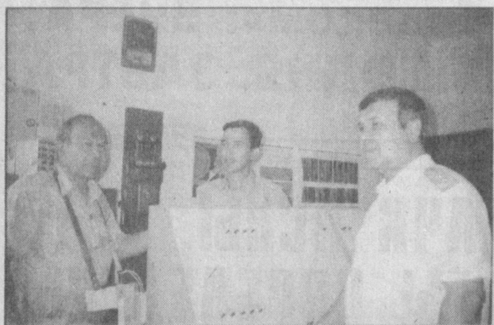
Специалисты Ургенчской дистанции сигнализации и связи (ШЧ-13) завершили пусконаладочные работы и сдали в эксплуатацию новую маршрутно-релейную централизацию на станции Элликала.
