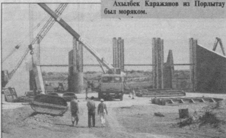
Здесь будет два Междуречья, а впереди - шлюзы водосброса.
