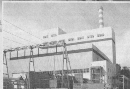
■ Пущенный в эксплуатацию в АО "Ангренская ТЭС" новый энергоблок мощностью 150 МВт с теплофикационным отбором для сжигания высококалорийного угля будет поставлять потребителям 840 млн кВт/ч электроэнергии в год.
