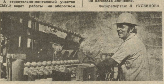
Строительно-монтажный участок СМУ-2 ведет работы на оборотном съезде за станцией «Лахут». Начальник участка Леонид Прусс сетует на недостаток бетона, арматуры, тучность кадров, чем и объясняет небольшое отставание от графика.
