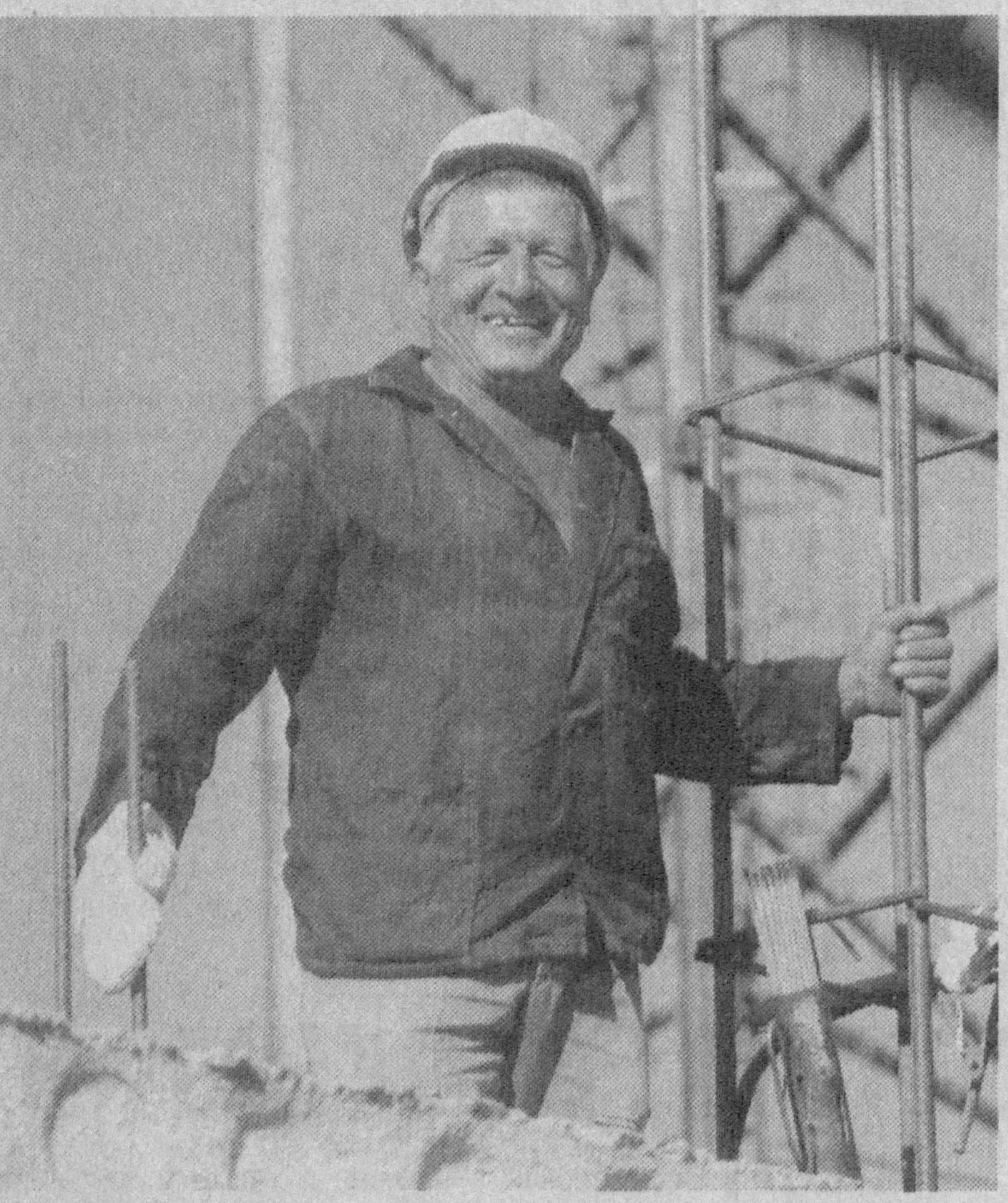
Строительно-инвестиционная фирма «Табус» ведет сооружение в столице жилых домов повышенной комфортности. НА СНИМКЕ: один из лучших бригадиров дочернего предприятия «Табус-курилиш тур» Нурулла Умаров руководит монтажом конструкций нового дома. Фото Рашида ГАЛИЕВА
